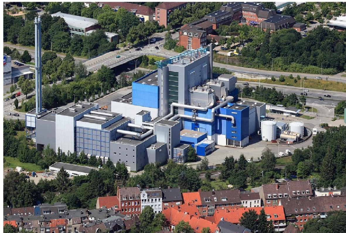
Instalacja w Kolonii (Niemcy)
